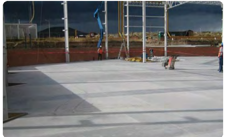
Industriële vloer – OC Puma-fabriek, Mexico.
