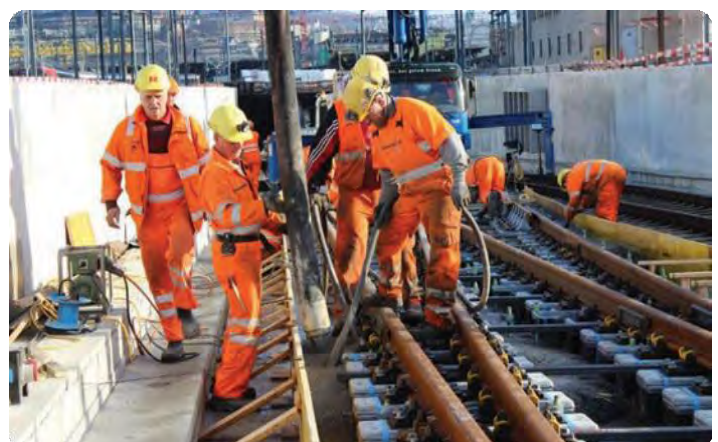
Bielzen spoorlijn – Zurich Diameter Line, Zwitserland.
